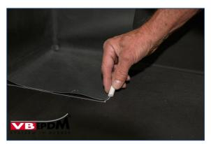
54. Mark sealing sleeve edge on membrane.
